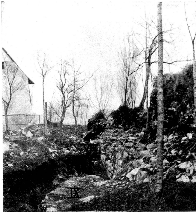
15. Kastell auf dem Kirchlibuck bei Zurzach. Mauertürme VIII und IX.
