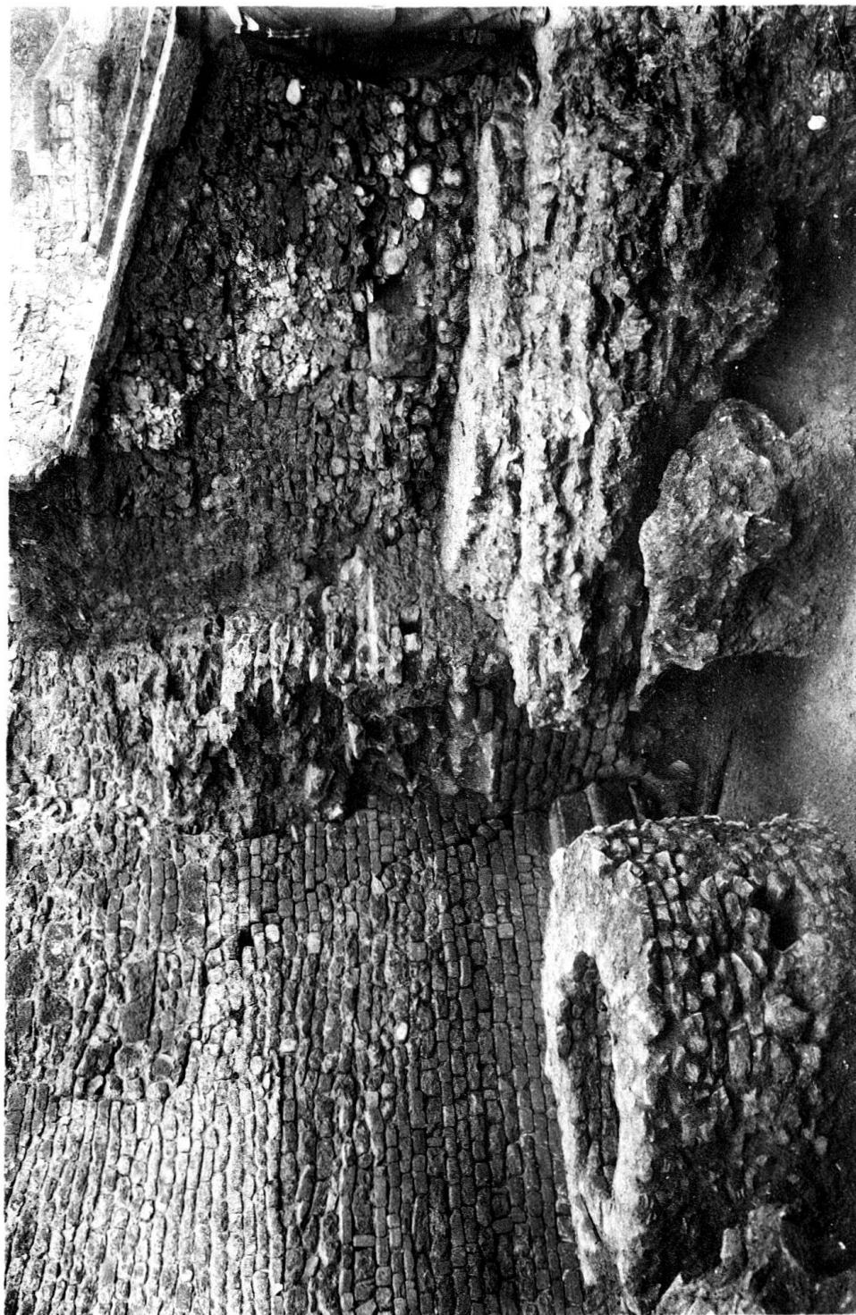
La voûte sous la Tour et le puits
