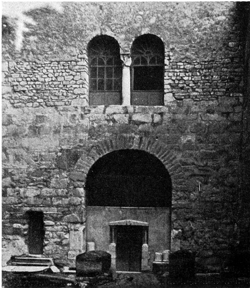
Fig. 1. Base de la tour de l'Abbaye, côté de la basilique.
