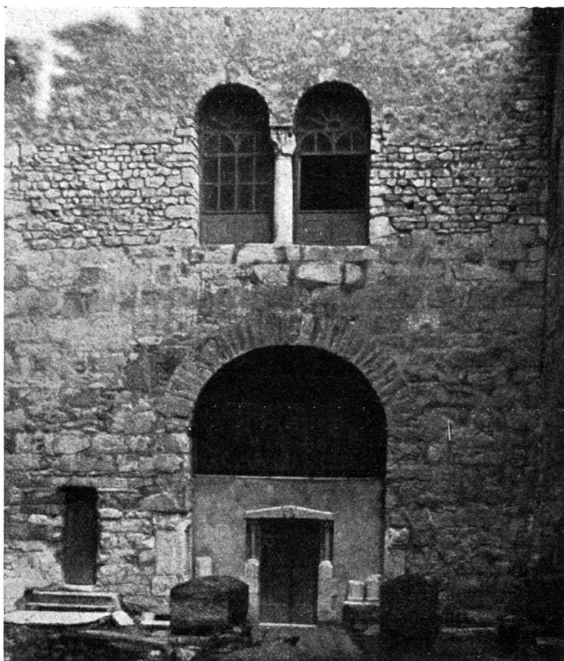
Fig. 4. Base de la tour, du côté des basiliques. Sarcophages antiques.
