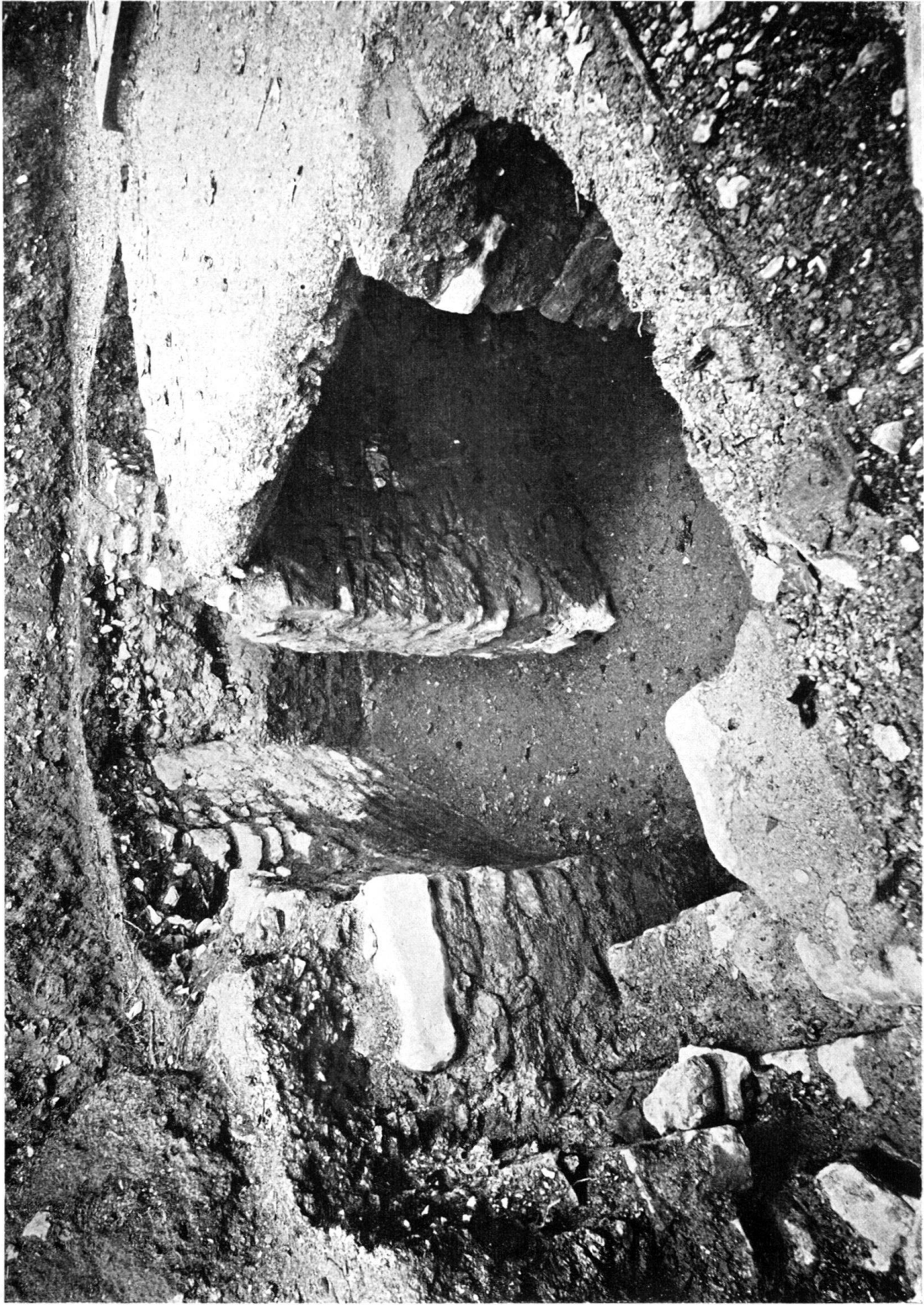
Le couloir en hémicycle et l'entrée de la Confessio, du Martyrium de St-Maurice.
