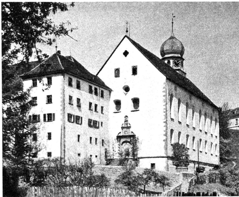
Abb. 3. Äußere Ansicht der Klosterkirche von Pfäfers.
