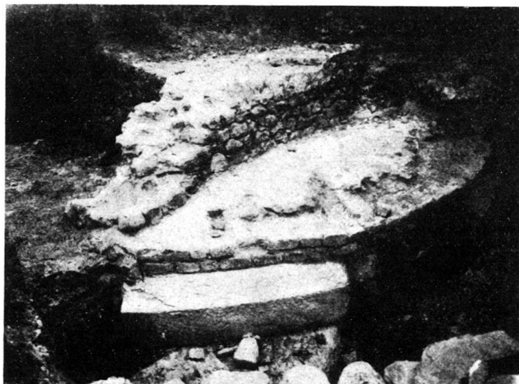
Fig. 10. La tour d'angle Sud-Est au cours des travaux. Fouilles 1906.
