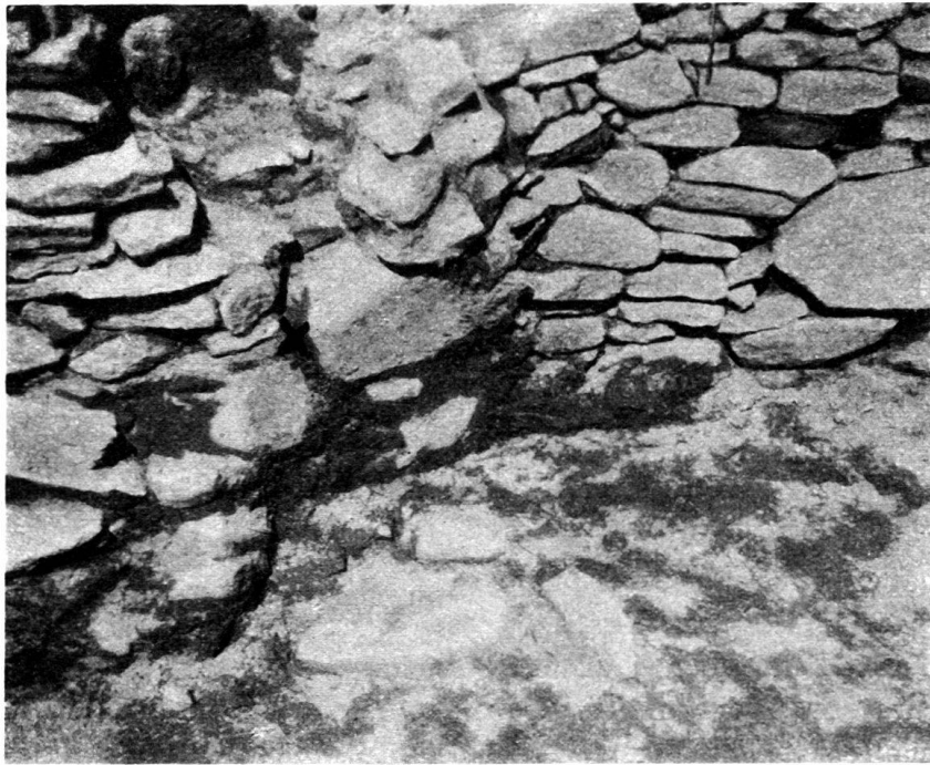
Abb. 4. Raum D. Ansatzstelle des Rechteckbaues der 2. Periode an den Rundbau der 1. Periode. Unten Herdstelle. × Höhe des Fußbodens der 2. Periode.
