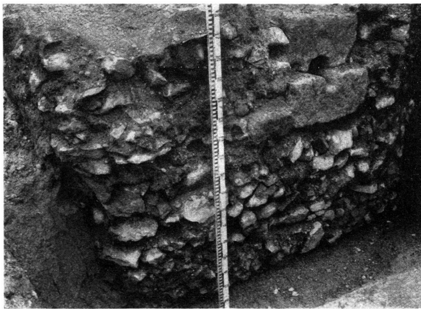
Abb. 4. Fundamentklotz im Kanal der Via principalis [F. 3].
