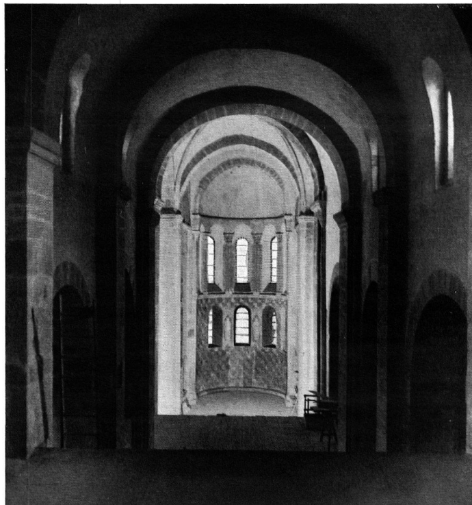
c. Blick in den Chor, vom noch nicht herausgebrochenen untersten Zwischenboden gesehen
