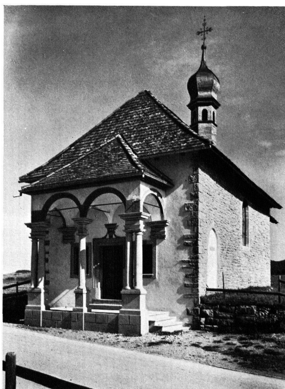
Abb. 4. Einsiedeln, Kapelle St. Gangulph nach der Renovation – Nachrichten S. 64
