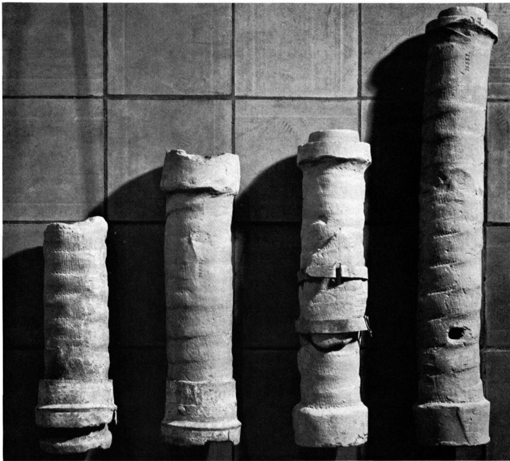
Tafel 35a. Zwei Röhrenstücke, links mit Zapfen, rechts mit Muffe. Der Verschluss weist zwei Anschläge auf. Das Zapfenstück links zeigt auf beiden Anschlägen einen ringförmigen Wulst, der in die Rille der Muffe (rechts) genau hineinpasst. (Slg. A. Gerster)
