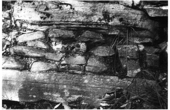
Abb.17 Castello di Tegna. Bindesteine in der westlichen Stützmauer (unter Kote 494, vgl. Abb.16)
