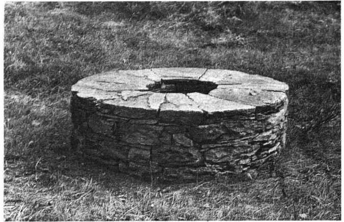
Abb. 33 Castello di Tegna. Sodbrunnen nach der Konservierung
