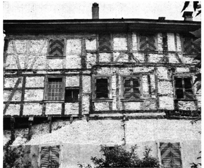
Abb. 17 Zug, Burg. Zustand nach Freilegung des Riegelwerks 1967. Blick von Norden gegen die Schildmauer und den darauf gesetzten Riegelbau in seinen einzelnen Bauphasen
