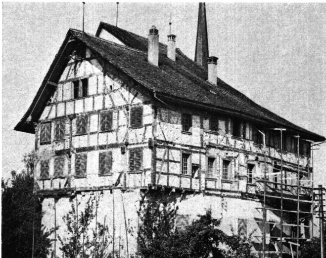
Abb. 18 Zug, Burg. Zustand nach Freilegung des Riegelwerks 1967. Blick von Osten mit auf die Schildmauer gestellten Riegelbauten. Im Hintergrund der First des Bergfrieds
