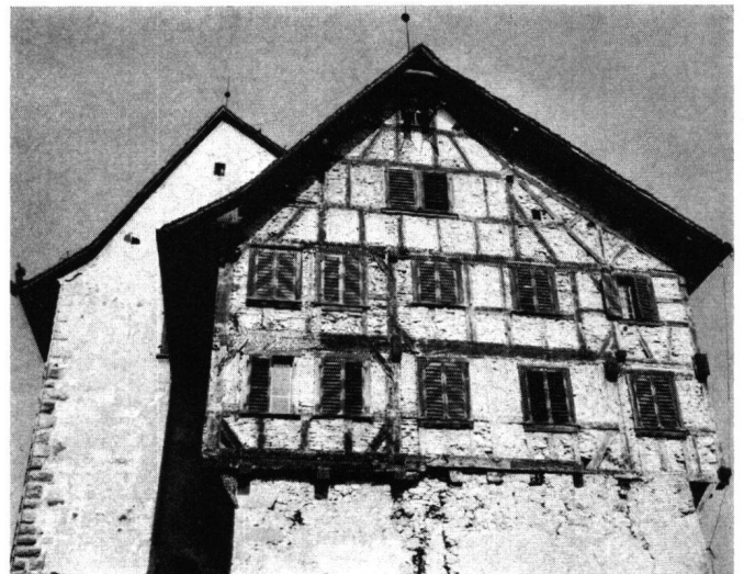
Abb. 19 Zug, Burg. Zustand nach Freilegung des Riegelwerks 1967. Blick von Südosten. Links der Bergfried, rechts der (später erweiterte) Riegelbau
