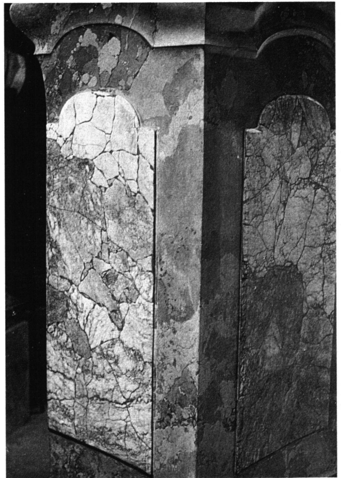
Abb. 3 Niederbüren, St. Michael, Hochaltar. Die Schilder aus grobem Alabastermosaik heben sich deutlich ab von den grau-rote Breccienstruktur zeigenden Stuckteilen
