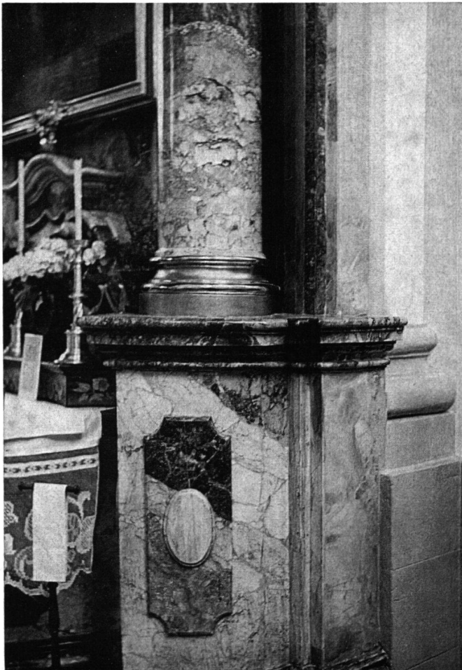
Abb. 1 St. Gallen, Stiftskirche, Notkersaltar. Mosaikartiger Überzug mit Platten aus natürlichem Alabaster verschiedener Färbung und Struktur
