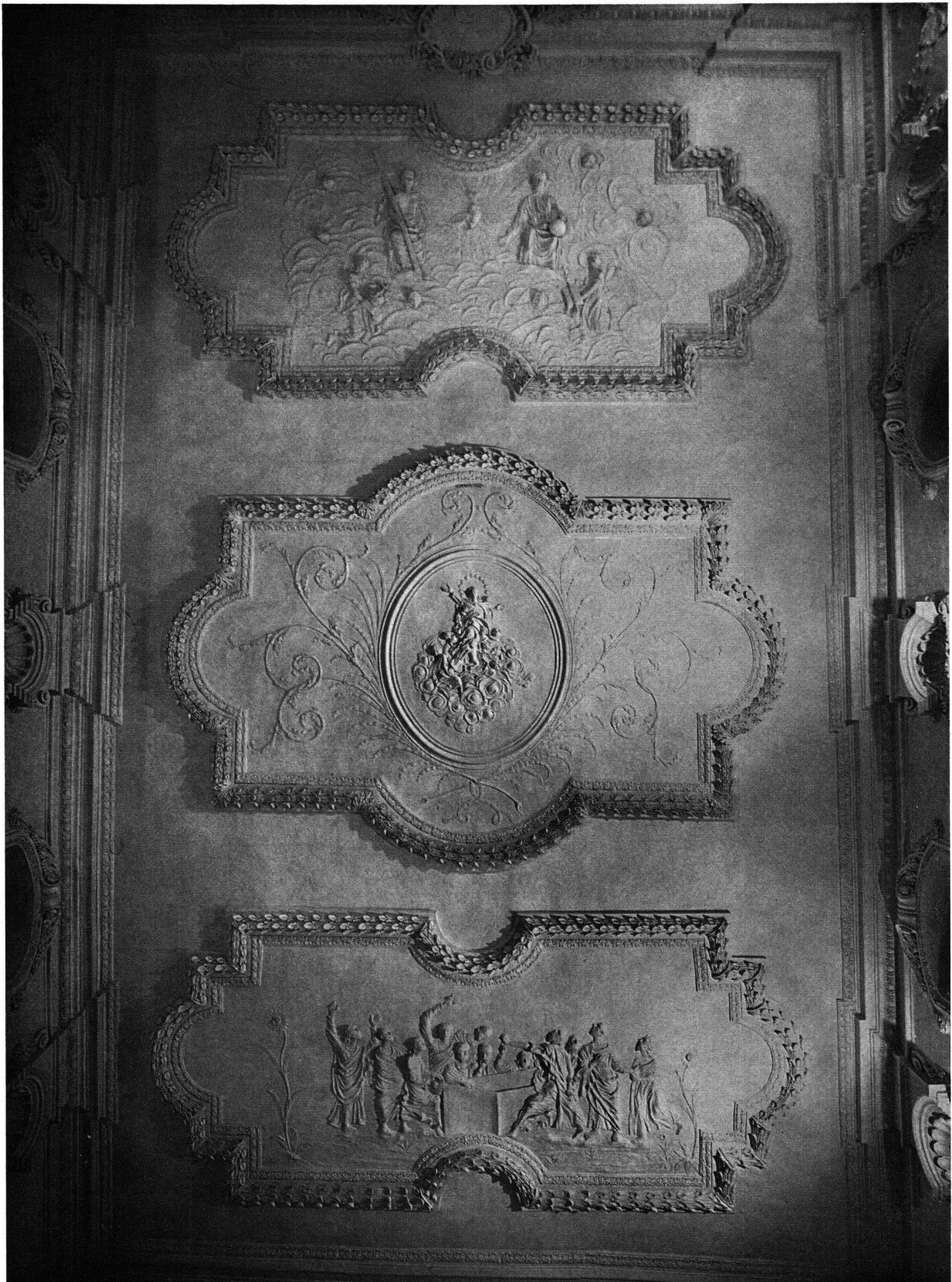
Abb. 28 Pruntrut, Jesuitenkirche. Stuckdecke im Schiff nach der Restaurierung
