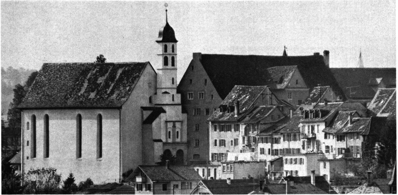
Abb. 7 Pruntrut, Jesuitenkirche und Kollegium. Ansicht von Nordosten (1968)
