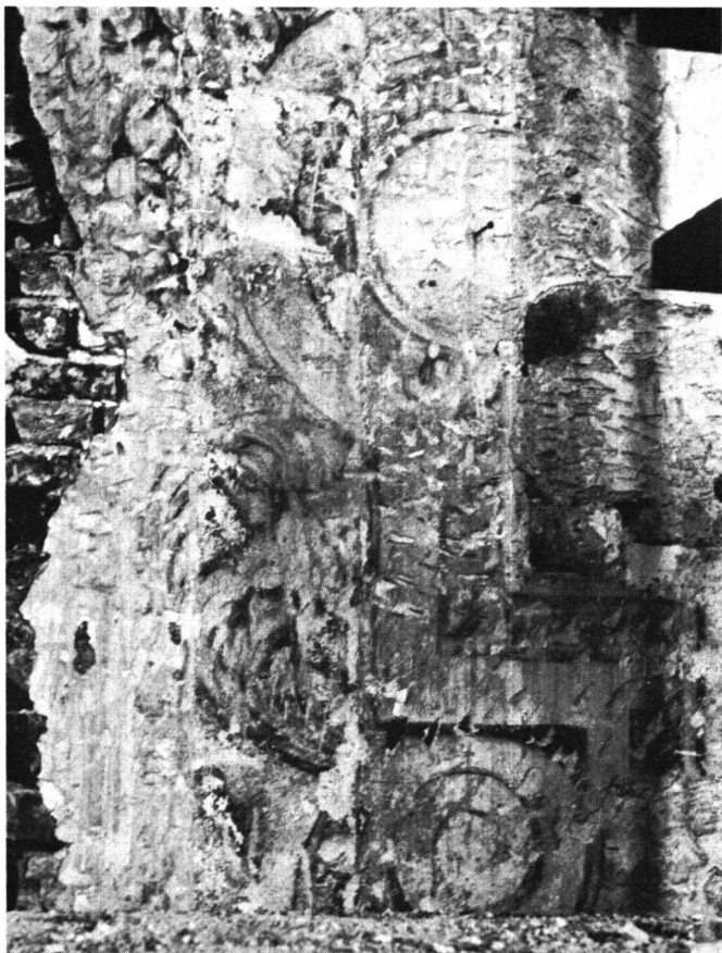
Abb. 21, 22 Pruntrut, Jesuitenkirche, Schiff, Südwand. Auf dem Wandputz hatte der Stukkateur die Stuckdekorationen säuberlich vorgezeichnet und in grauer Farbe plastisch vorgemalt. Unter dem neuen Wandputz der Turnhalle war diese Bemalung erhalten, so daß sogar die ursprünglichen Löcher für die Zirkeleinsätze festgestellt und wieder benützt werden konnten. – 21 Vorzeichnung. 22 Rekonstruktion in Stuck
