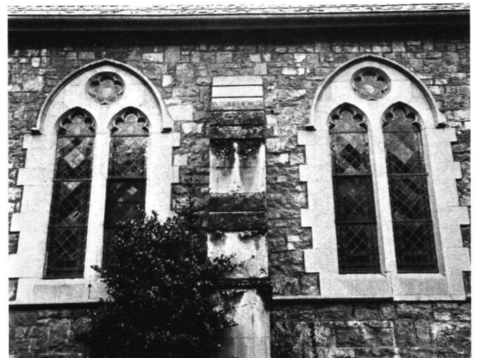
Fig. 18 Street: L'église anglaise de Vevey, bâtie en 1880. Fenêtres de la nef
