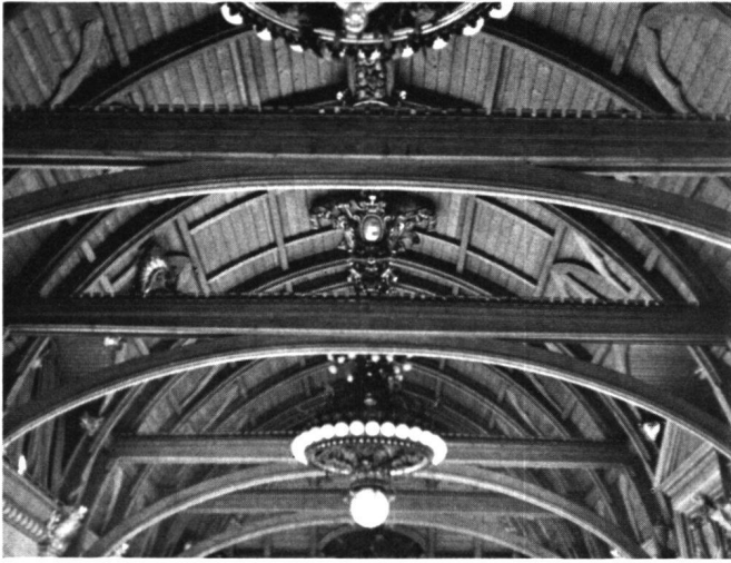
Abb.12 A.Koch: Schulhaus am Hirschengraben in Zürich, Dachstuhl des FestsaaIs. 1891–1893
