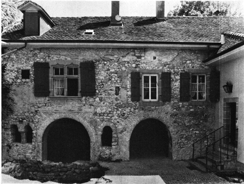
Fig. 2 Vue générale de la façade ouest des bâtiments conventuels durant les travaux de 1971
