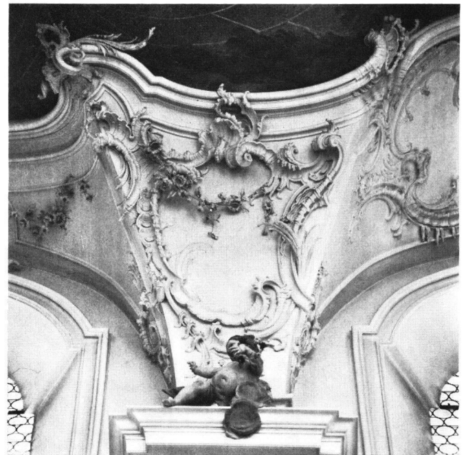
Abb.62 Chor Nordseite: Kartusche am zweiten Gewölbeanfänger von Westen, 1754
