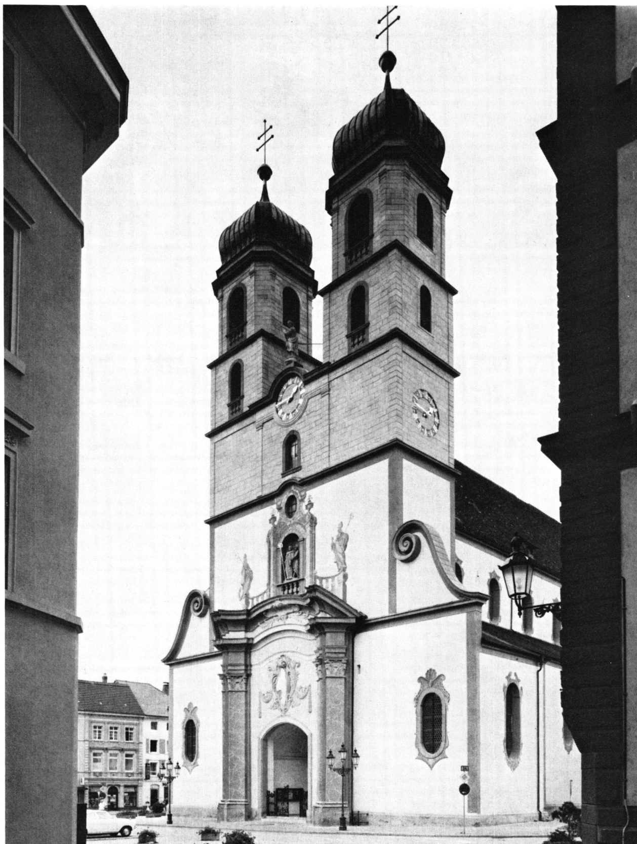
Abb. 107 Münsterfassade, Zustand nach der Restaurierung 1974
