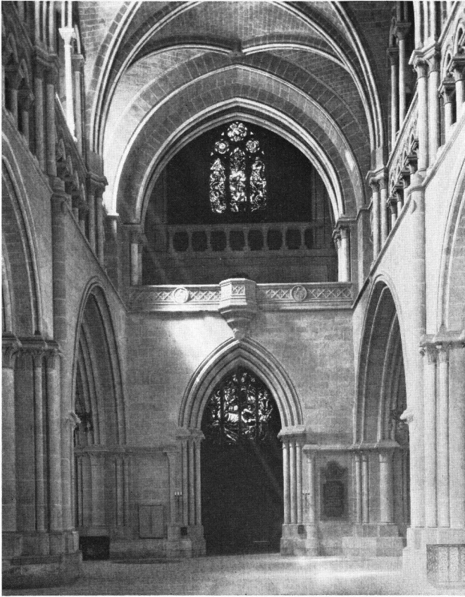
Fig. 3 Vue intérieure des parties occidentales de la cathédrale: «grande travée», tribunes inférieure et supérieure, sans les orgues (Photo de Jongh, BCL)
