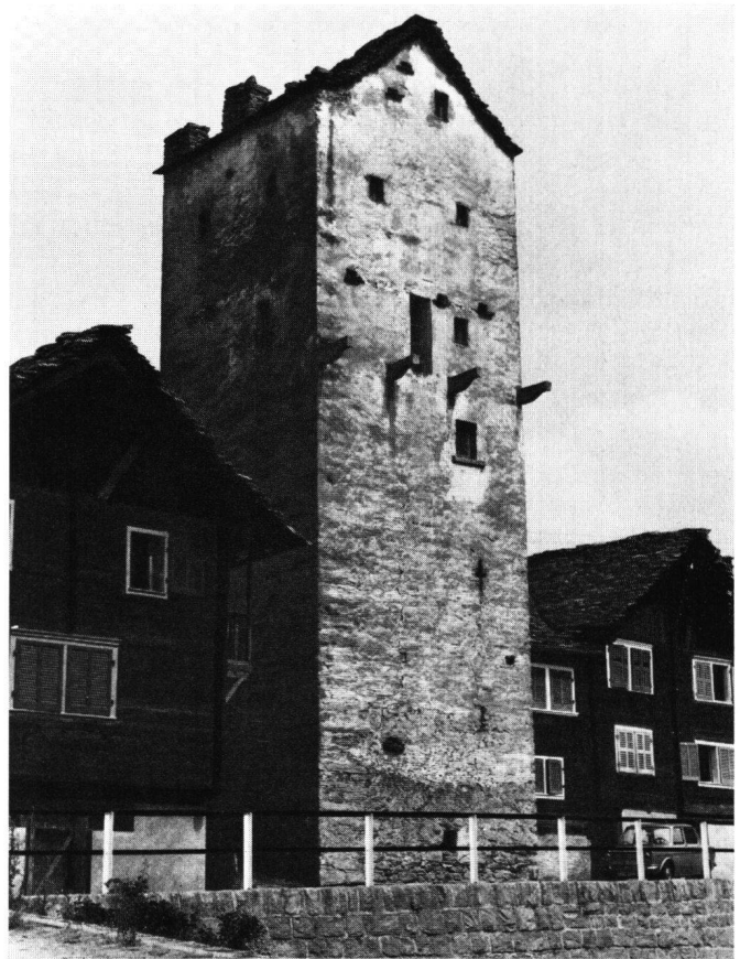
Abb. 1 Chironico, Torre dei Pedrini (TI). In repräsentativer Weise überragt der wehrhafte Turm die hölzernen Bauernhäuser
