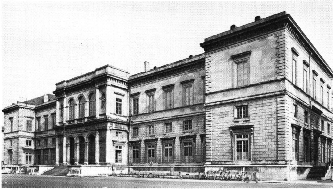
Fig. 6 J.A.Froelicher: Le Collège latin, Neuchâtel. Vue du nord-ouest
