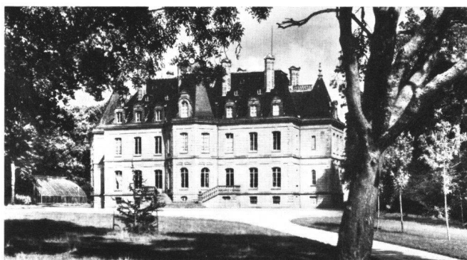
Fig. 22 J.A.Froelicher: Vue du château de Kernévez (Finistère)
