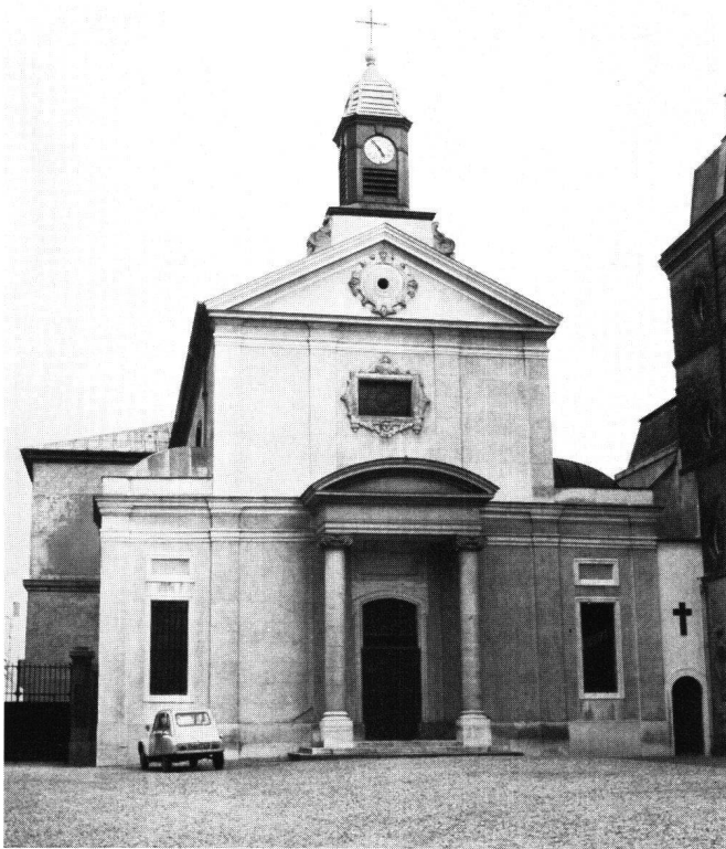
Fig. 11 J.A.Froelicher: Façade principale de la chapelle expiatoire de Picpus, Paris
