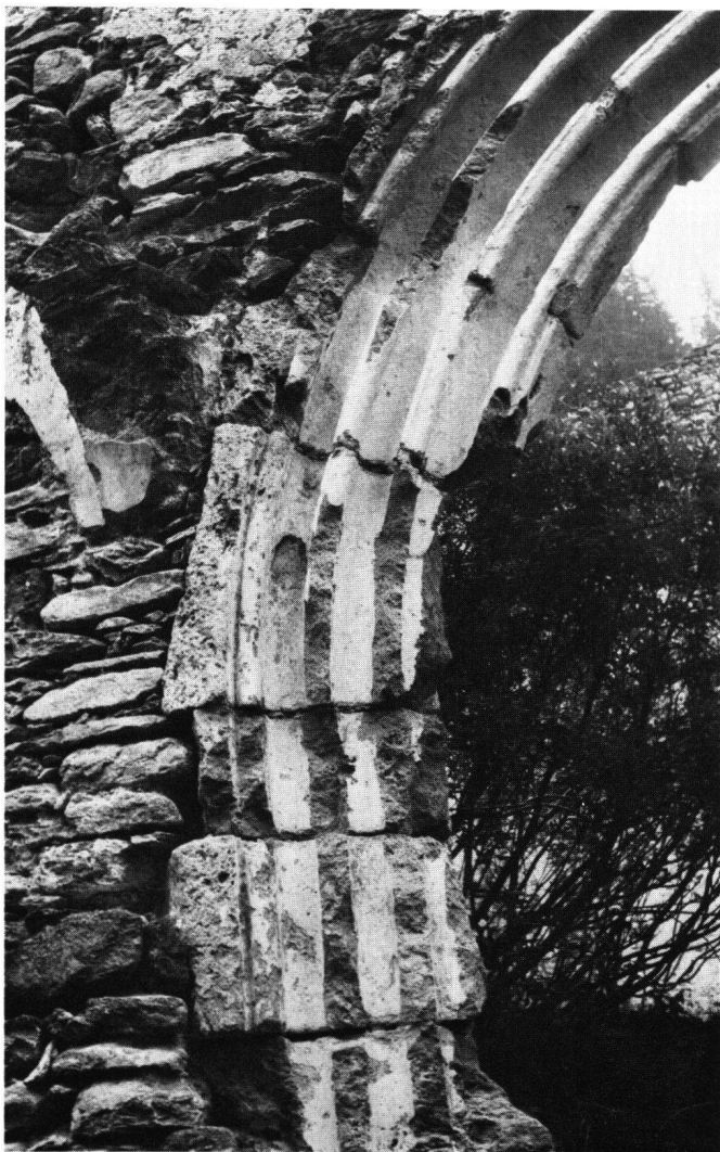
Abb. 5 Portalgewände aus ockergelber Rauhwacke an der Kirchenruine S. Gaudenzio bei Casaccia im Bergell (1518). Die Steine sind beschädigt, aber nicht verwittert
