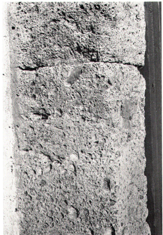
Abb. 4 Detail des Portalgewändes aus Rauhwanke am Turm des Schlosses Spiez. Typisch die zellige Struktur der hier ausnahmsweise wenig gelben Oberfläche
