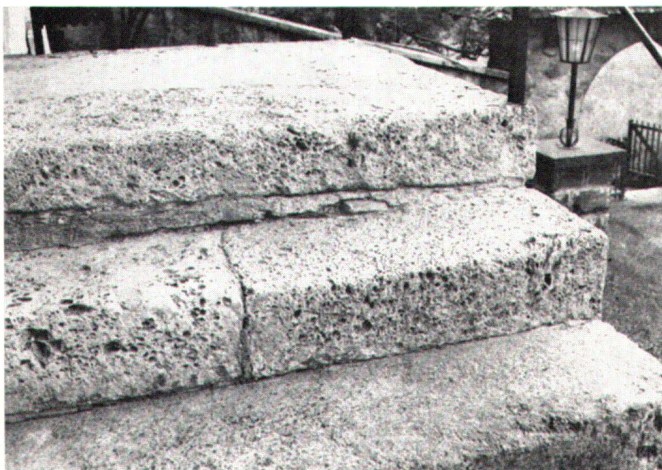
Abb. 2 Außentreppe aus Rauhwanke der Kirche Saanen. Die Verwendungsart zeugt für die Festigkeit und Beständigkeit des grobzellig-löcherigen Gesteins
