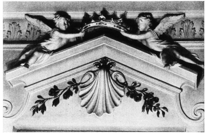
Abb. 13 Fribourg, Château de La Poya: Dreieckgiebel der Südwand
