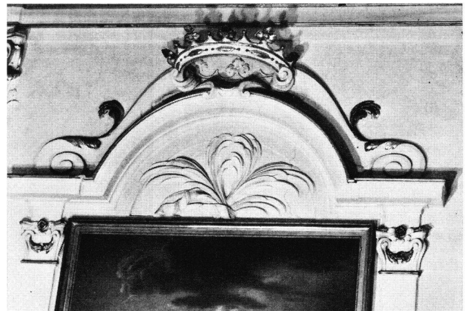
Abb. 15 Fribourg, Château de La Poya: Segmentgiebel der Westwand
