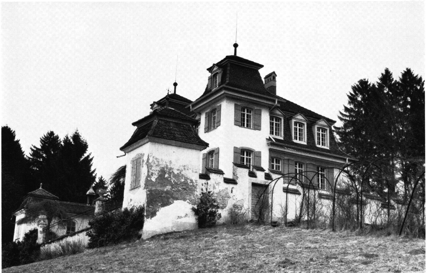
Abb. 9 Landsitz Hüenberg von Südwesten
