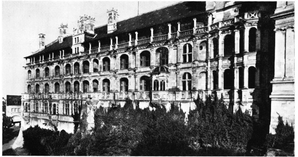
Abb. 9 Das Schloß von Blois. Ansicht von der Stadtseite, 1515–1524
