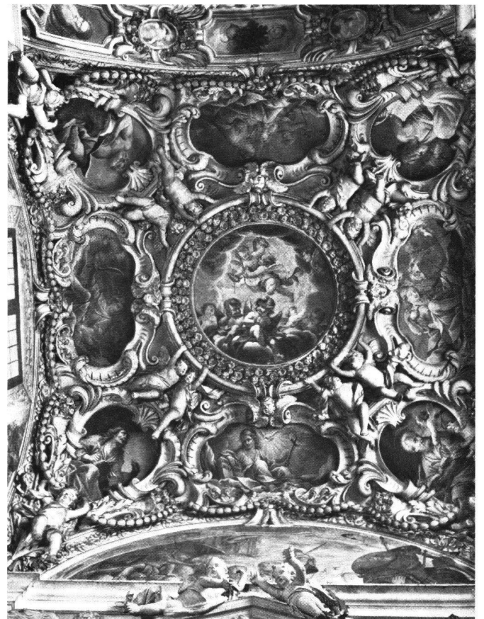
Abb. 11 Bissone, Kirche S. Carpofo; Chorgewölbe
