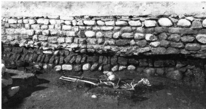
Fig. 16 Parement intérieur du mur sud de la nef romane
