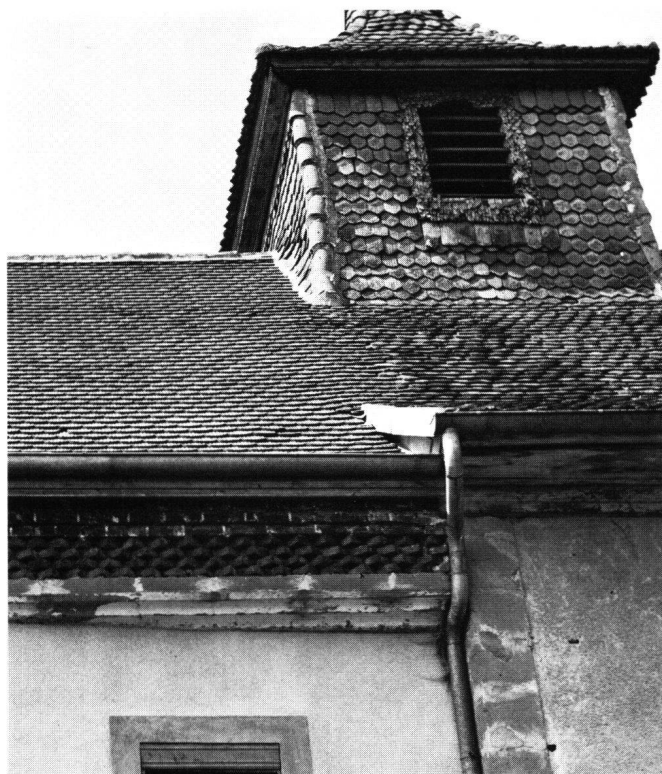
Fig. 19 Corniche méridionale de la cure, en molasse et en briques
