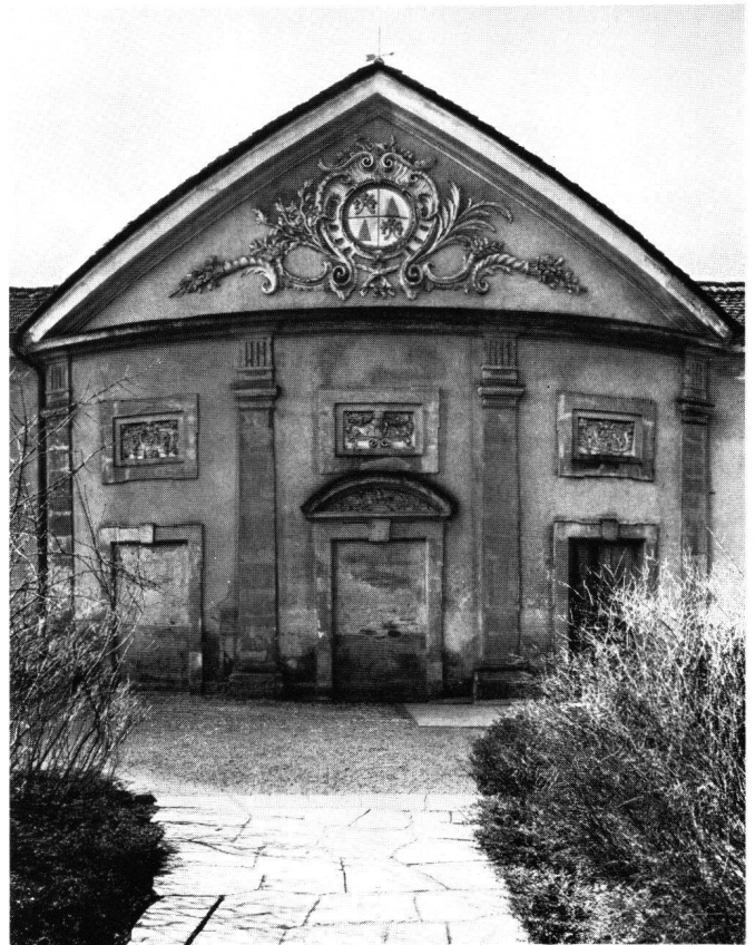
Abb. 7 St. Urban, ehemaliges Klostergebäude, Orangerie von Jakob und Niklaus Purtschert, Mittelpavillon, 1777/80
