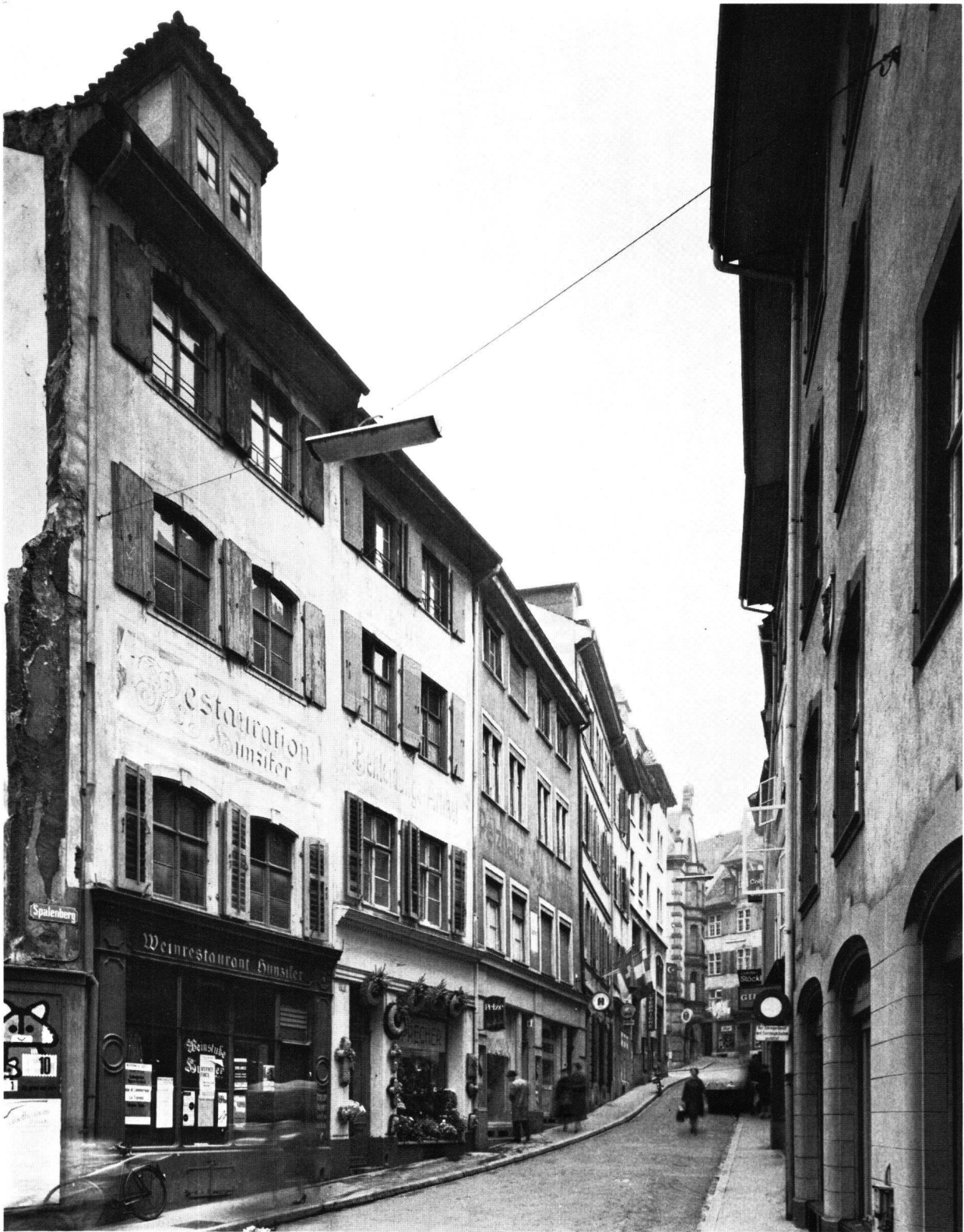
Abb. 1 Das Haus Spalenberg 5 in Basel, sogenanntes «Grünes Haus»; abgebrochen 1966. Wohnhaus und Besitz von Hans Herbst von 1501 bis 1535 (im Bild Haus ganz links)
