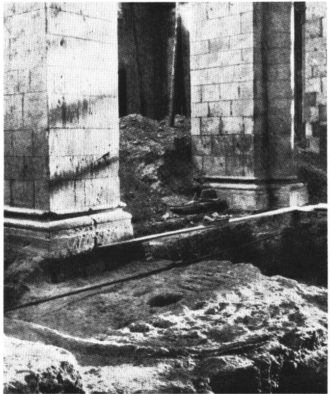
Abb. 13 Mönchengladbach. Ansicht der Mörtelscheibe von Südwesten. Besonders auffällig sind hier die konzentrischen Wellen.
