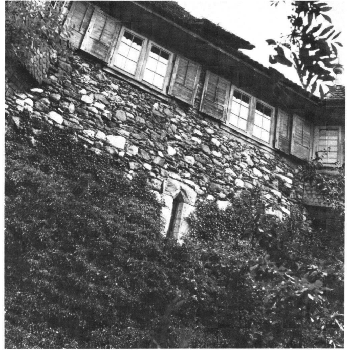
Abb. 8: «Hardturm» (Hardturmstrasse 136): Das mit dem Turmganzen im Verband stehende Licht gehört in die zweite Hälfte des 13. Jahrhunderts.
