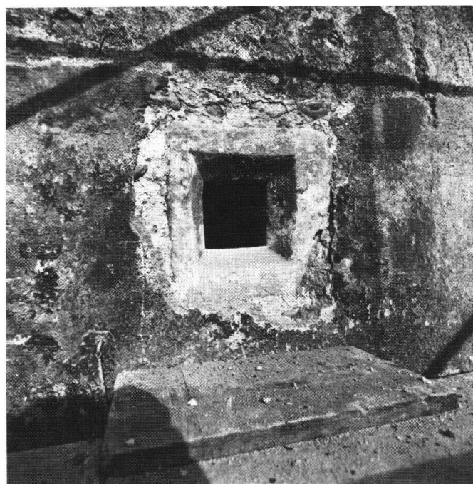
Abb. 7 Aussen- und Innenansicht des Lochfensters oder Spions von etwa 1330 in der westlichen Brandmauerscheibe des hofseitigen Kernbaus.
