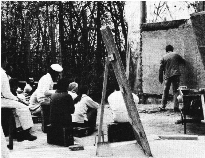
Abb. 5 Wandkurs im sechsten Semester, technologischer Teil. Demonstration historischer Putztechniken mit Kalkmörtel.
