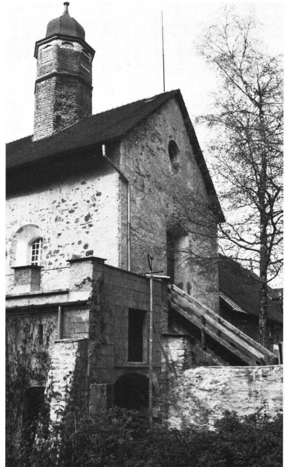
Abb. 9 Kartause La Part-Dieu. Südostecke der Kirche mit baulichen Resten des grossen Kreuzganges.
