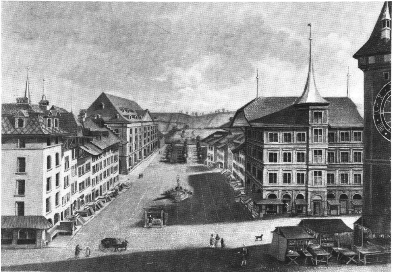
Abb. 2 Ansicht des Kornhausplatzes von Johann Grimm , um 1740. Öl auf Leinwand, 34×48 cm. Rechts im Bild das Gesellschaftshaus zu Pfistern, erbaut 1595–98 von Daniel Heintz dem Älteren.
