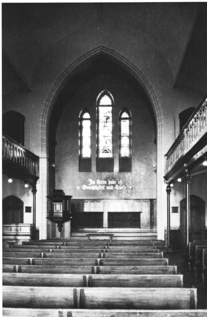
Fig. 10 Chapelle du Valentin. Intérieur. Etat après la rénovation de 1934.
