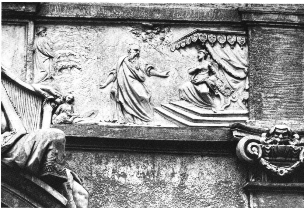
Fig. 11 Ascona, casa Serodine, particolare della facciata con il rimprovero di Nathan a Davide.
