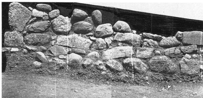
Abb. 54 Mauerecke mit einem auf dem gewachsenen Boden errichteten Teilstück von 3 m Länge.
