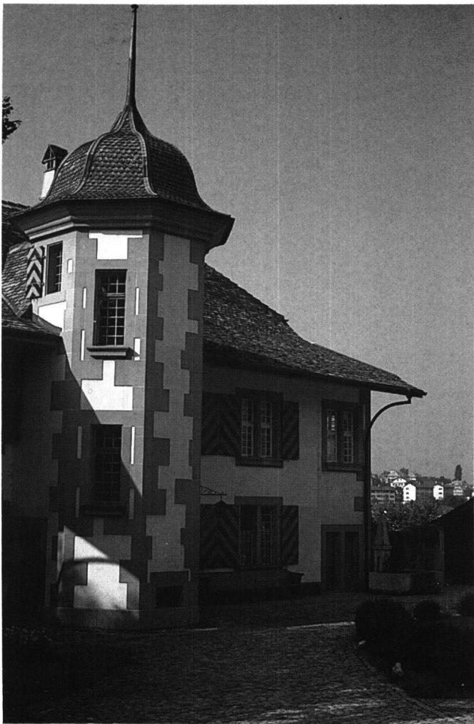
Abb.7 Ittigen/BE, Thalgut, Spätform des nachgotischen Herrschaftshauses mit Wendelstein. Die regularisierte Fassade und die «welsche Haube» bereits im Zeitstil des 17. Jahrhunderts.
