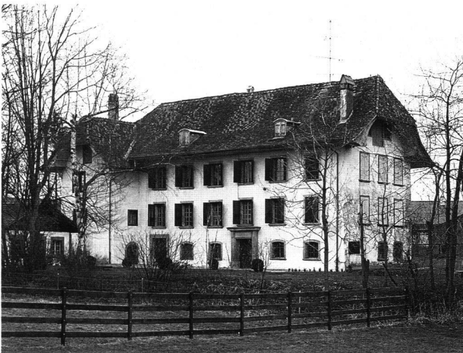
Abb.5 Misery, Herrenhaus mit spätmittelalterlichem Kern. Ansicht von Nordwesten von 1988.
