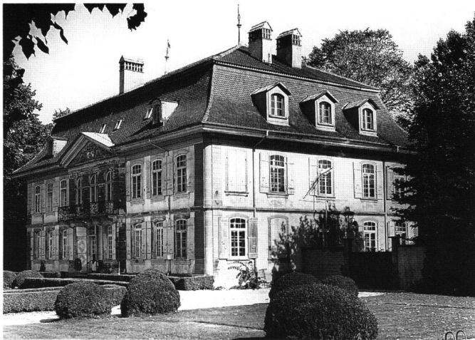
Abb. 13 Middel, Herrenhaus de Griset de Forel, gebaut 1748/49 nach Plänen des Architekten Johann Paul Nader. Blick von Südwesten auf das Hauptgebäude. Aufnahme 1984.
