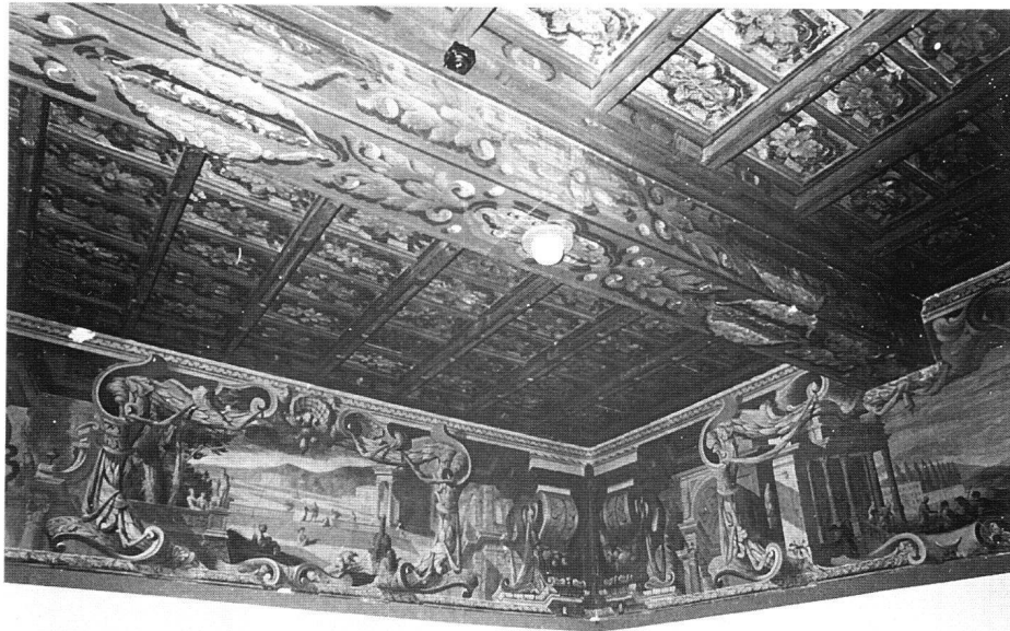
Fig. 16 Veduta del VI locale con le pareti 3 e 4.
