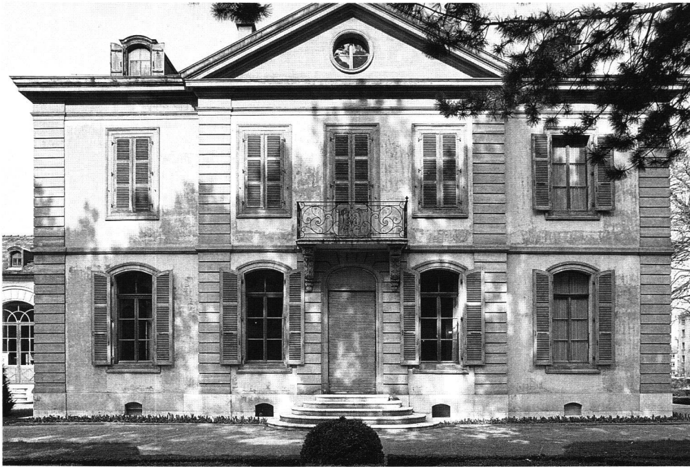
Fig. 6 «Les Délices», Genève. Façade sur jardin (sud) dans son état de 1987 (avant restauration).
