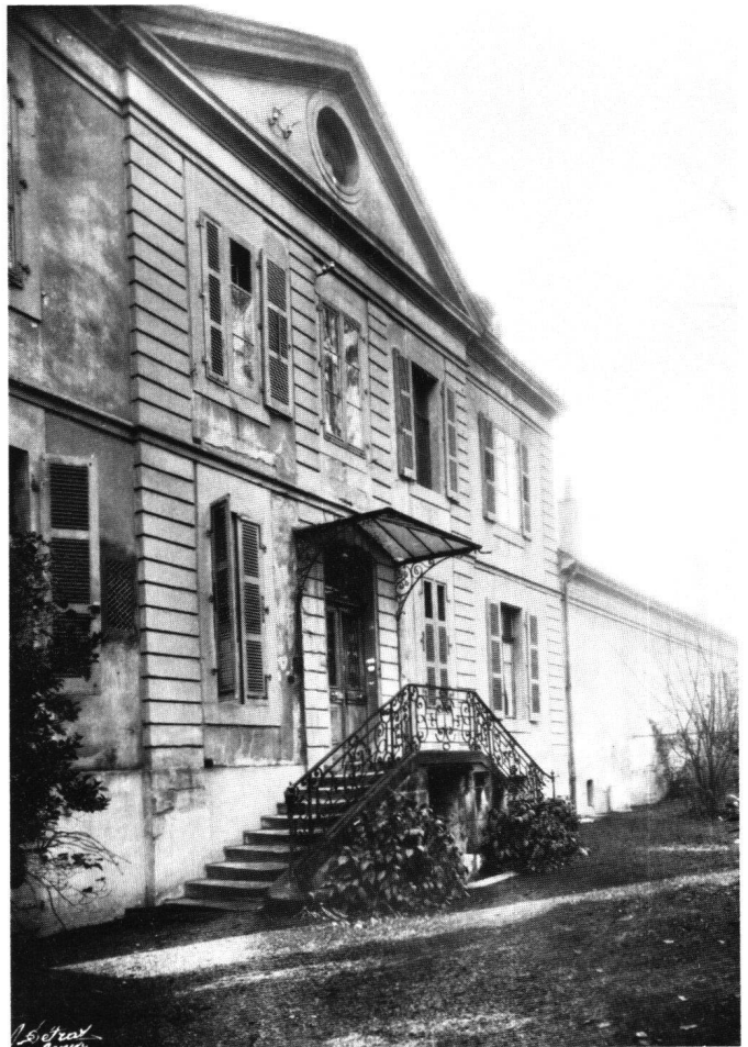
Fig. 1 «Les Délices», Genève. Façade d'entrée sur cour (nord) dans son état de 1930.
