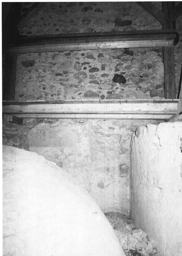
Abb. 14 Dachraum des südlichen Abseits (Aufnahme 1985).
