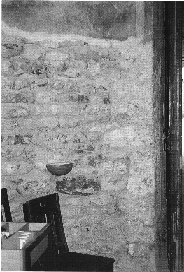
Abb. 28 Muratur der südlichen Innenwange der Westapsis (Aufnahme 1985).
