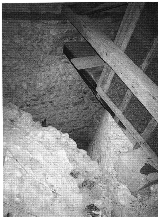
Abb. 37 Zwickelschacht zwischen der Nord-Exedra, der Apsis und der Nordmauer der nördlichen Abseite (Aufnahme 1993).
