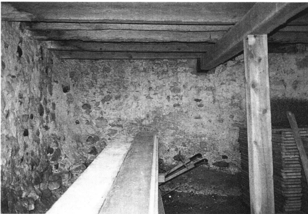
Abb. 41 Südwestlicher Bereich des nördlichen Kellers (Aufnahme 1993).
