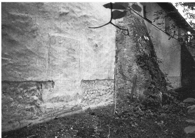
Abb. 43 Östliche Partie des nördlichen Seitenschiffes mit einer vermauerten Tür (Aufnahme 1983).
