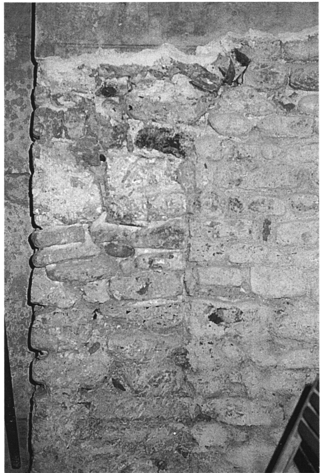
Abb. 27 Südliche Ansatzstelle der Innenwangen der Westapsis zur Westmauer des Langhauses (Aufnahme 1985).
