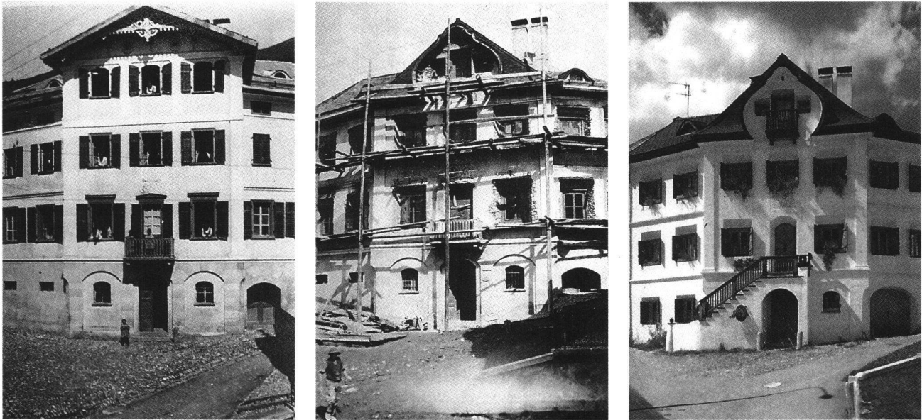
Abb. 6 Die Metamorphose des Hauses Prof. Pult am oberen Platzrand von Sala in Sent hat für den gesamten Wiederaufbau des abgebrannten Dorfes Symbolcharakter. Links: Zustand des 1864 erbauten, streng klassizistischen Hauses vor dem Brand von 1921. Mitte: Zustand während der Wiederherstellung bzw. des Neubaus unmittelbar nach dem Brand von 1921. Rechts: Das fertige Haus im Gewande traditioneller einheimischer Architektur, heutiger Zustand.
