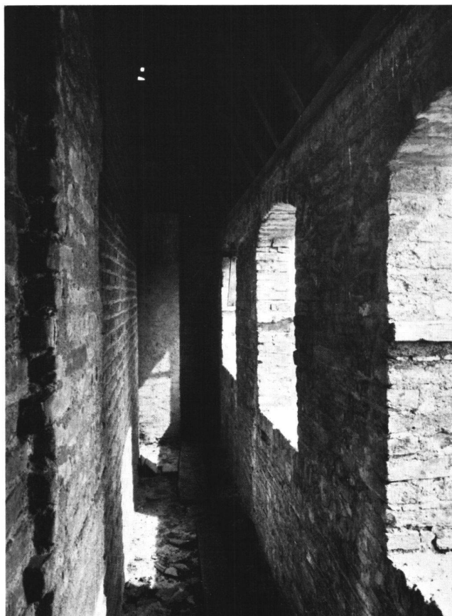
Fig. 42 Château de Vufflens. La coursière de la tour sud-est du «donjon» avec le mur intérieur et le parapet à mâchicoulis.
