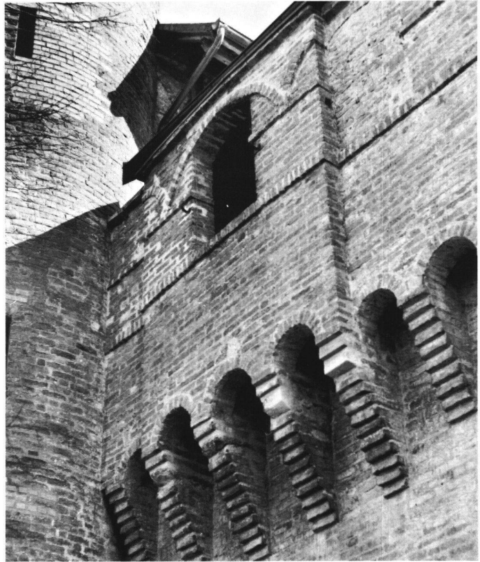
Fig. 45 Château de Vufflens. La «bretèche» des mâchicoulis de la courtine nord de la cour, surmontant l'entrée principale.
