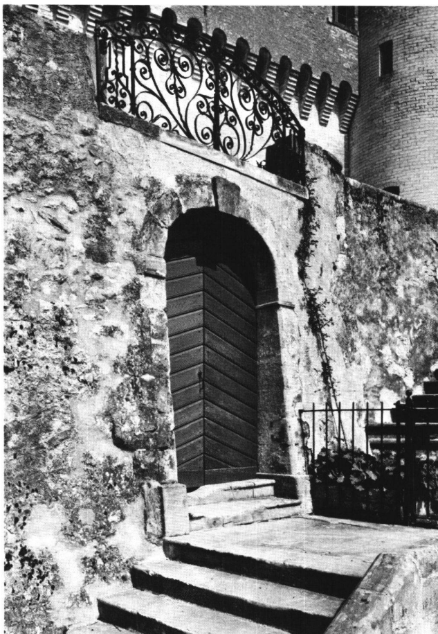
Fig. 26 Château de Vufflens. L'extérieur de la poterne, surmontée de l'appui en ferronnerie (avant 1780) remplaçant l'ancienne bretèche.
