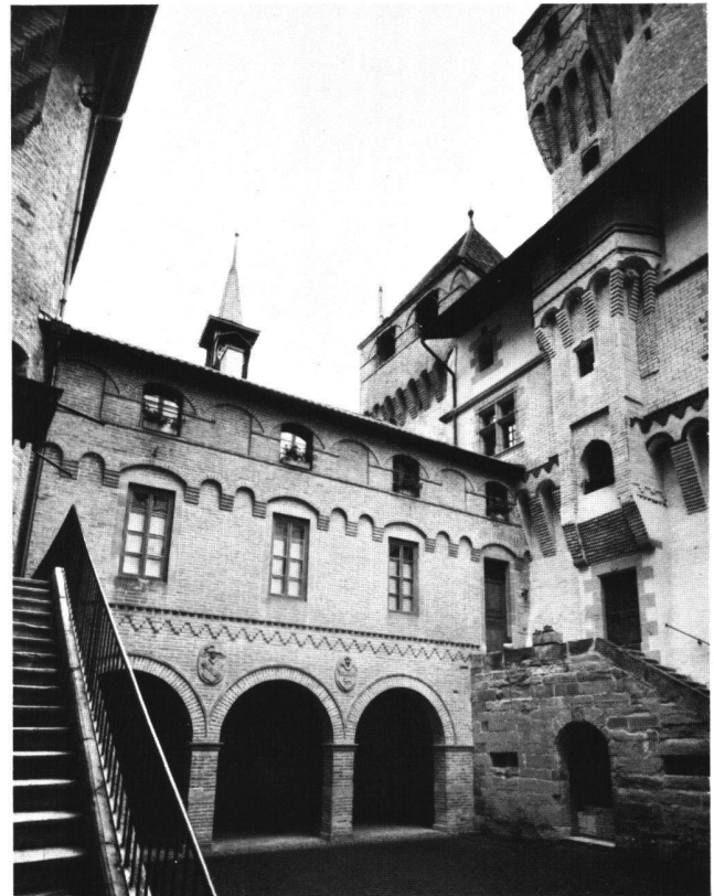
Fig. 18 La cour du château de Vufflens, avec l'aile à portique de 1850 et le «donjon». Etat actuel.
