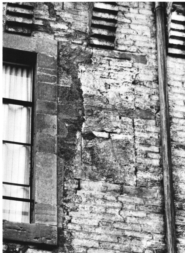
Fig. 52 Château de Vufflens. La fenêtre du XV e siècle, coupée et murée, au deuxième étage du corps de logis, du côté du Bourg.
