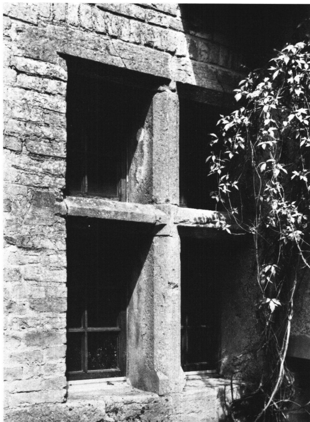
Fig. 51 Château de Vufflens. La fenêtre sud de la «cuisine» du donjon.
