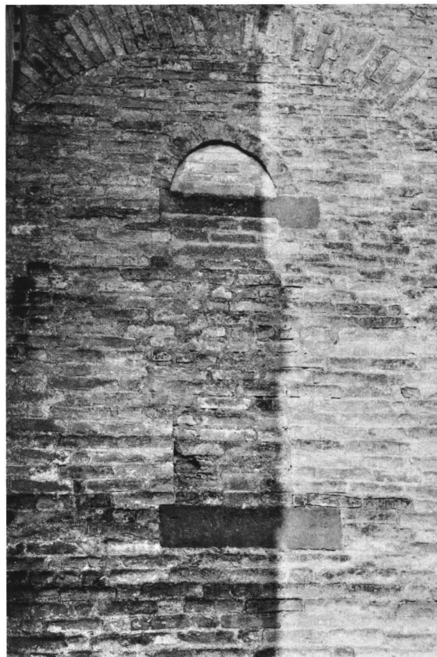
Fig. 43 Château de Vufflens. La porte haute, entrée primitive du donjon, avant son démurage.
