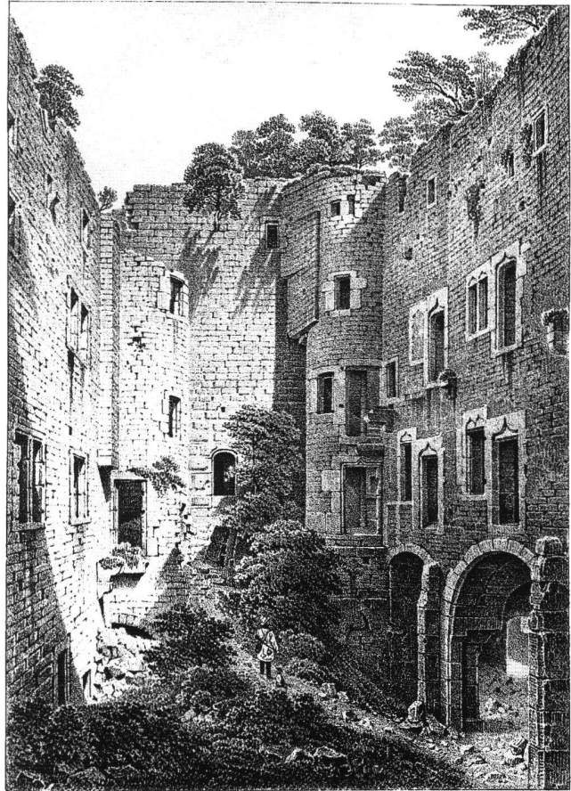
Abb. 4 Die Ruine 1839. Innenhof (Ehrenhof) mit Blick nach Osten auf den Bergfriedstumpf mit staufischem Buckelquaderwerk und Zangenlöchern im unteren Teil. Im Zwickel von Bergfried und Südpalas (rechts) der Ort des eingestürzten und von Ehardt rekonstruierten Treppenhauses (vgl. Abb. 10).
