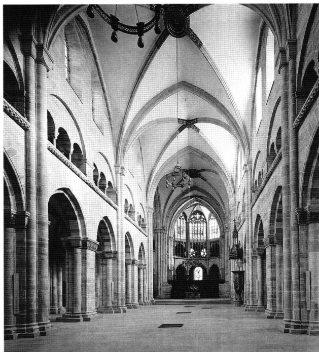
Abb. 1 Basel, Münster: Mittelschiff gegen Osten (Zustand nach den jüngsten Restaurierungen).
