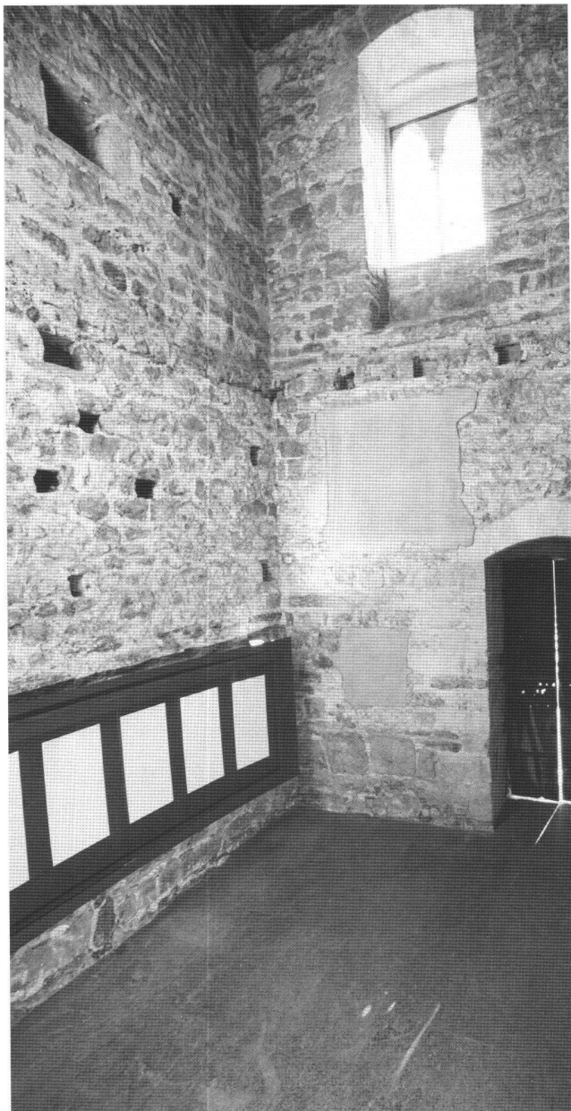
Fig. 4a Pavimento in lastre ruvide di Onsernone e bacheca applicata al muro.
